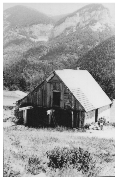
En arrière fond, la montagne de Belle Motte
